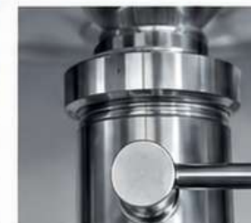
Soudure TIG brossée extérieur d'un manchon
