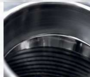
Soudure interne, rasée et polie, du col de la cheminée
